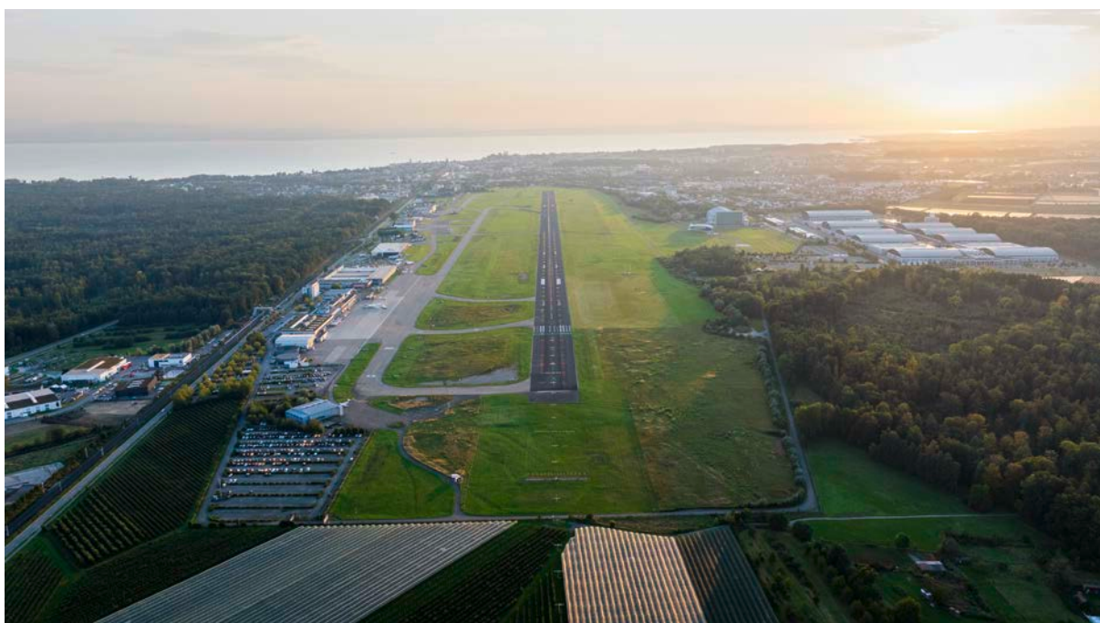
Der Flughafen Friedrichshafen ist von großer Bedeutung für die wirtschaftsstarke Bodenseeregion
